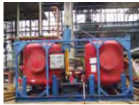
BTX ใช้ Activated Carbon ที่มีขนาดเหมาะสมรองรับไอสารอินทรีย์ระเหยจากงาน Decontamination
