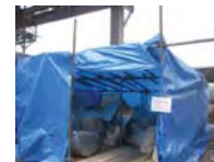
มีการจัดเก็บ Insulation ในที่ร่มและแยกแหว่ง Insulation และ Cladding เพื่อให้ง่ายต่อการนำกลับมาใช้งาน
