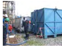
EBSM งาน Clean Heat Exchanger มีการเตรียมถังพักตะกอน ตะกอนบนสไลด์อยู่ในถัง ก่อนปล่อยน้ำเสียเข้าระบบของ plant
