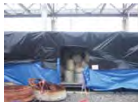
มีการจัดเก็บ Insulation ในที่ร่มและแยกแหว่ง Insulation และ Cladding เพื่อให้ง่ายต่อการนำกลับมาใช้งาน
